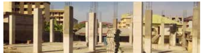
Neue Schule im Aufbau / New school under construction
